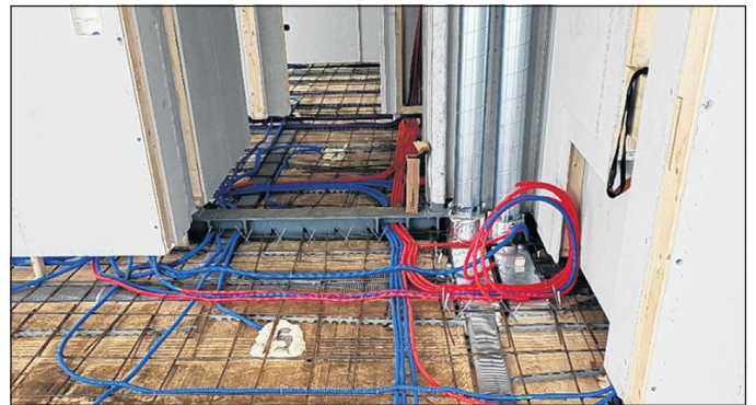
Auf den Holzboden werden verschiedene Leitungen (Lüftung, Strom) verlegt, bevor der Flüssigbeton darauf gegossen wird.
