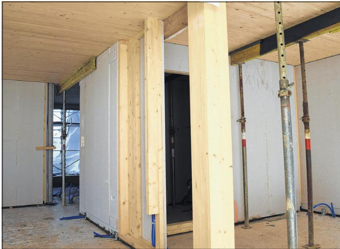
Im Rohbau ist bereits einiges Holz nicht mehr sichtbar, so etwa im Boden. Nur Decke und Holzstützen im Balkonbereich werden sichtbar bleiben.
